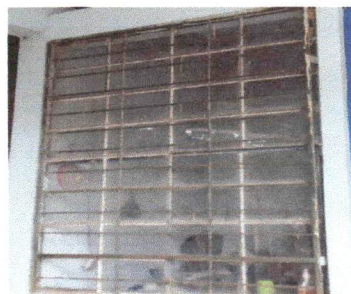
Foto 4: Sustitución de ventanas por balcones
