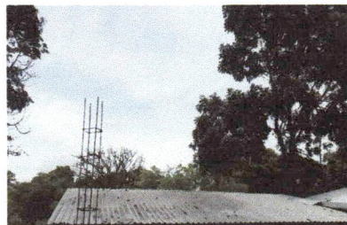
Foto 2: Sustitución de techo
