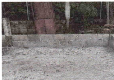
Foto1: Remozamiento de muro, mejoramiento y seguimiento de muro existente
