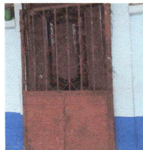
Foto 6: Sustitución de puerta, en mal estado
