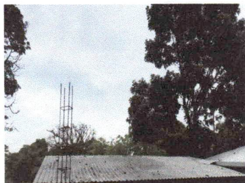
Foto 3: Sustitución de estructura de techo
