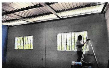
Foto 4: Sustitución de ventana de vidrio por aluminio y vidrio.
