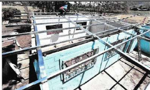
Foto1: sustitución de estructura de soporte de madera, por metal
