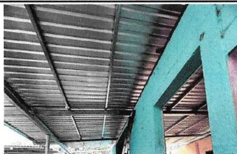
Foto 2: Sustitución de lámina, por lámina troquelada de aluzinc calibre 26
