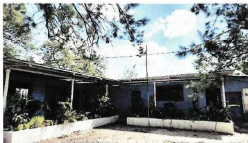
Foto 6: Pintura en muros exteriores e interiores.
