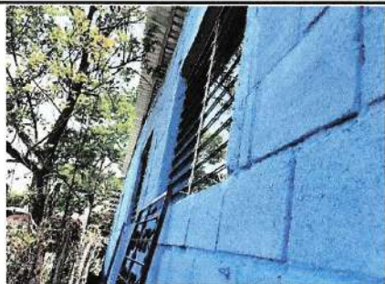
Foto 5: Sustitución de balcones de metal
