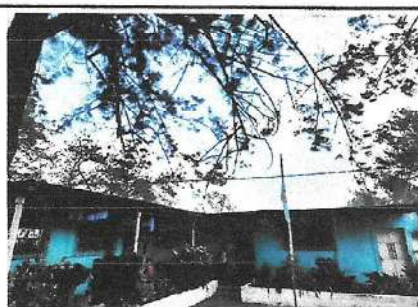
Foto 6: Pintura en muros exteriores e interiores.
