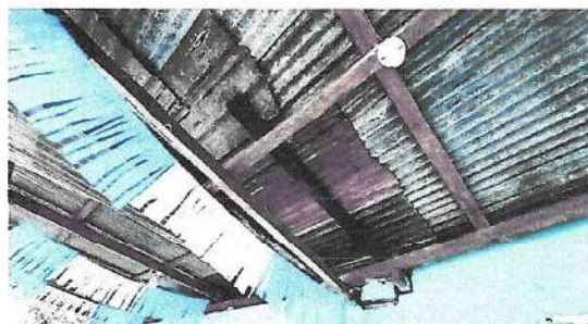
Foto 2: Sustitución de lámina, por lámina troquelada de aluzinc calibre 26
