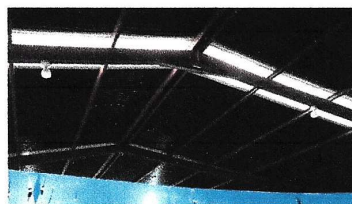
Foto 2: Reparación del sistema eléctrico.
