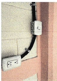
Foto 3: Reparación del sistema eléctrico.
