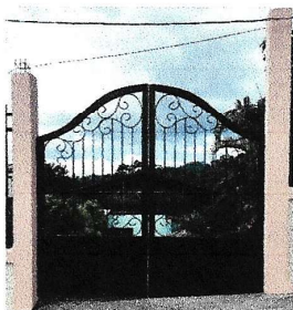
Foto 5: Sustitución de portones.
