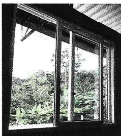
Foto1: Sustitución de estructura de metal de ventana.
