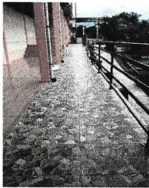
Foto 7: Sustrución de piso cerámico antideslizante.
