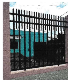
Foto 6: Mantenimiento y sustitución de barandas de metal.
