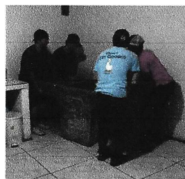
Foto 10: Sustrución de pila de cemento de dos lavadereos en cocina.
