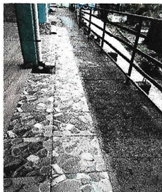
Foto 7: Sustrución de piso cerámico antideslizante.
