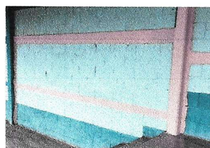
Foto 12: Pintura en muros exteriores e interiores.
