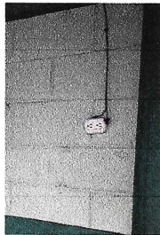
Foto 3: Reparación del sistema eléctrico.
