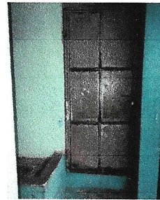
Foto 4: Reparación y mantenimiento de puertas de metal.
