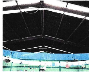
Foto 2: Reparación del sistema eléctrico.
