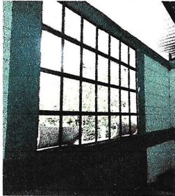
Foto 1: Sustitución de estructura de metal de ventana.
