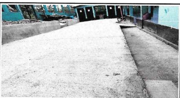
Foto 12: losa de patio lista
