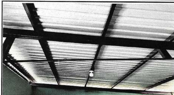
Foto 1: energía eléctrica arreglada
