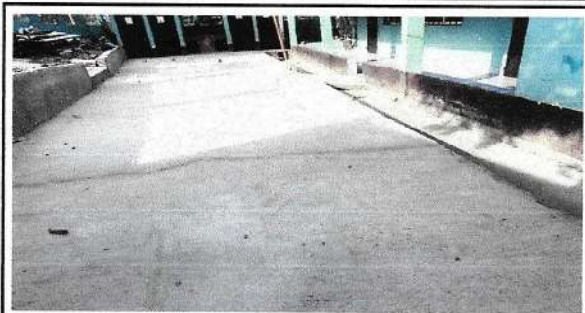
Foto 8: losa de patio arreglada
