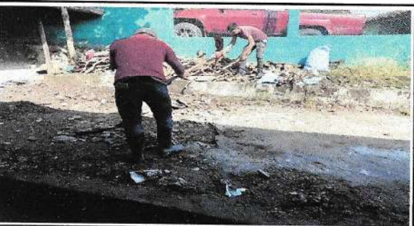
Foto 5: losa de patio en proceso
