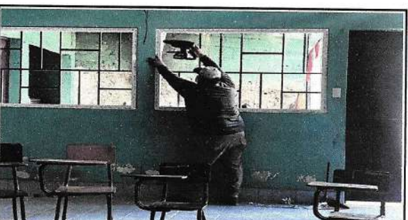
Foto 6: instalación de ventanas
