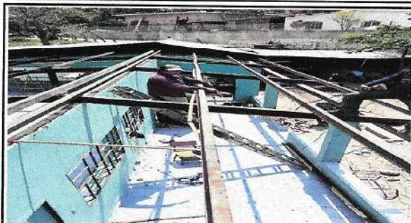
Foto 2: pintando la estructura
