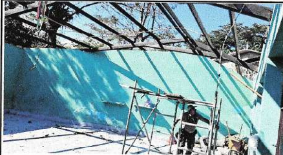
Foto1: colocando el techo
