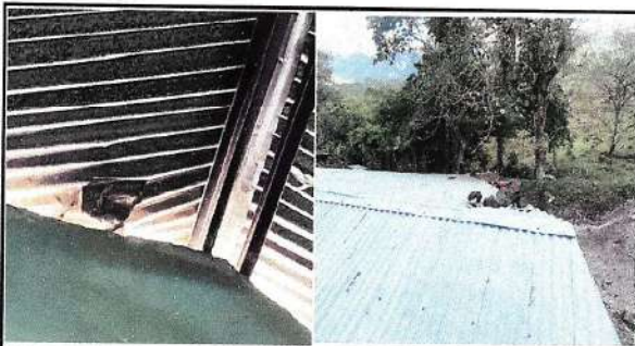
Foto 6: agujeros y filtración de agua en techo
