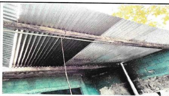
Foto 4: estructura de madera
