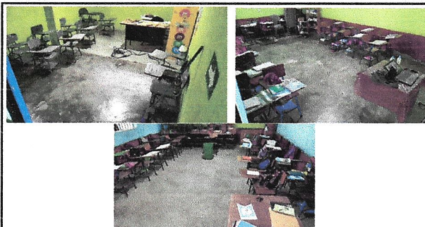
Foto 3: Sustitución de piso cerámico
