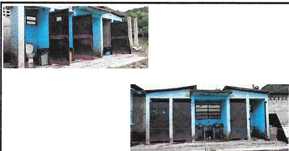
Foto 5: Mantenimiento a estructura de puertas.
