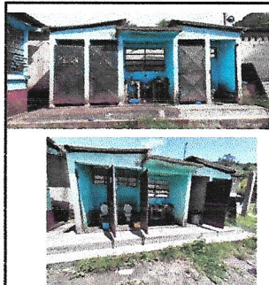
Foto 2: Sustitución de Piso cerámico y azulejo en sanitarios.
