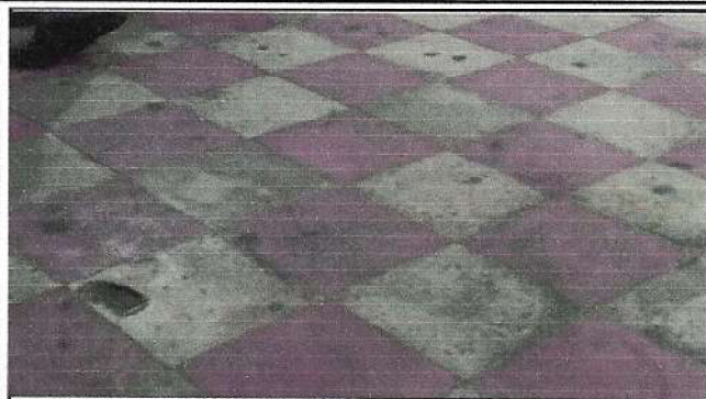
SUSTITUCION DE PISO DE GRANITO
