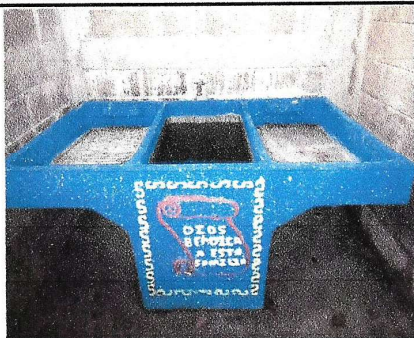
FOTO 1. Sustrucción de pila de cemento de dos lavaderos.
