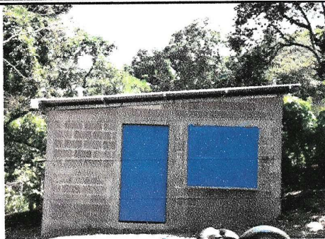
FOTO 2. Reparación de muro perimetral de block en cocina.
