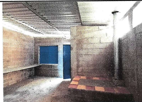
FOTO 6. Sustrucción de estufa rural (completa) incluye chimenea y plancha de metal.
