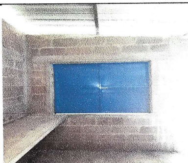
FOTO 5. Sustrucción de balcón.
