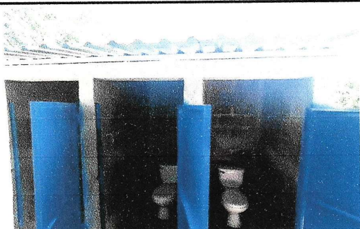
FOTO 3. Sustrucción de inodoros.
