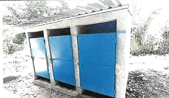
FOTO 4. Sustrucción de puertas para baños.
