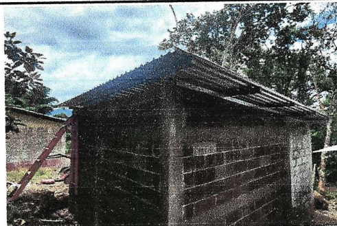
FOTO 2. Sustrucción canal de metal.
