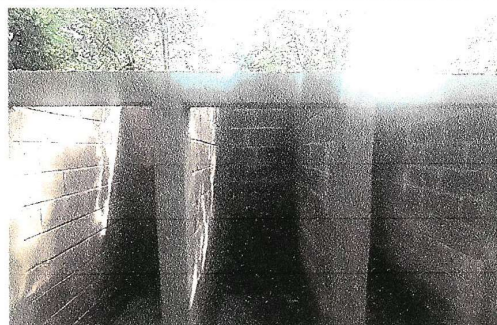
FOTO 4. Sustrucción de puertas para baños.
