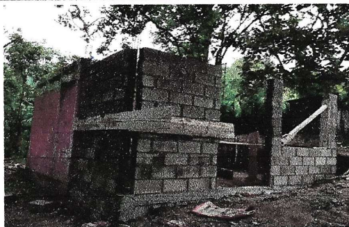
FOTO 2. Reparación de muro perimetral de block en cocina.
