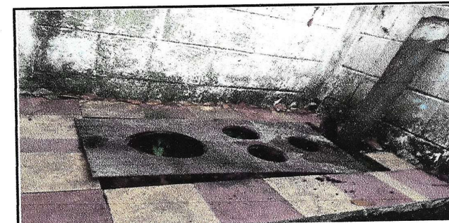
FOTO 6. Sustrucción de estufa rural (completa) incluye chimenea y plancha de metal.
