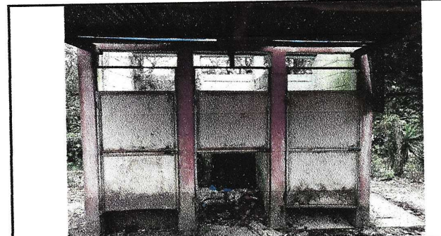
FOTO 4. Sustrucción de puertas para baños.
