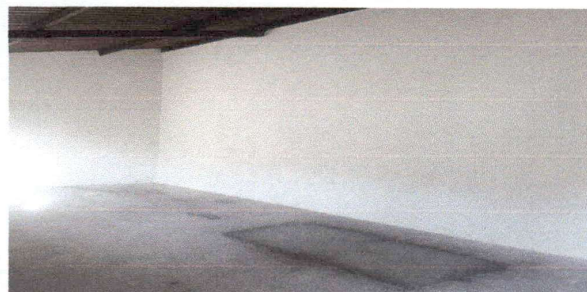
Foto 4: Se repelló y cernió paredes
