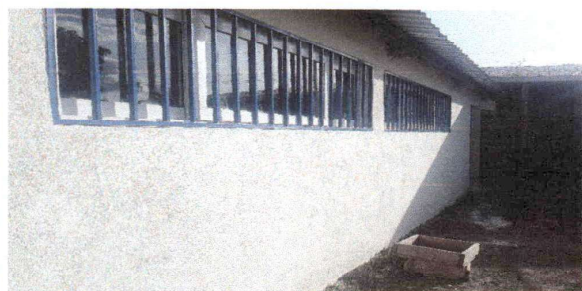
Foto1: Se remozó y mejoró muro existente
