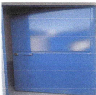
Foto 5: Se sustituyó puerta en mal estado
