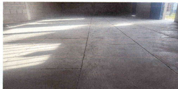
Foto 2: Se reparó piso de torta de concreto
