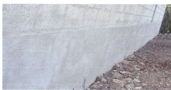
Foto 6: Se aplicó Impermeabilizante en pared
