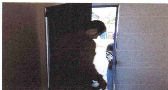
Foto 5: Sustitución de puerta en mal estado
