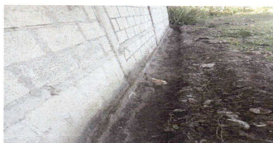
Foto 6: Aplicación de Impermeabilizante en pared
