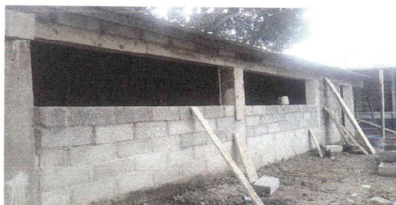
Foto1: Remozamiento y mejoramiento de muro existente
