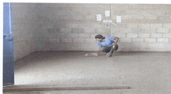
Foto 2: Reparación de piso de torta de concreto
