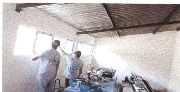
Foto 3: Sustitución de balcón y ventana de metal
