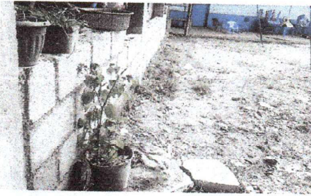
Foto 1: Remozamiento de muro, mejoramiento y seguimiento de muro existente
