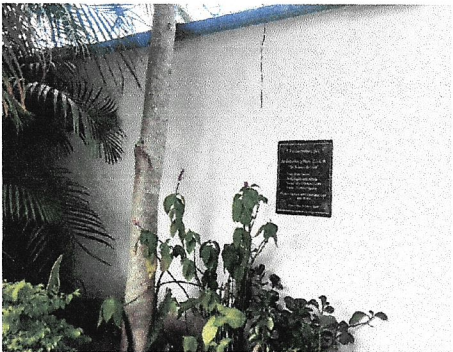
Foto 5: Repello y cernido de paredes (cuando aplique)
