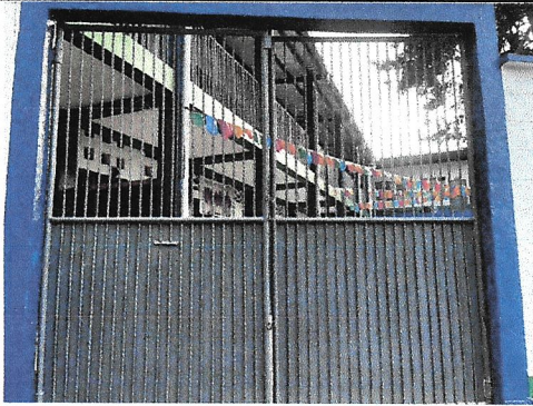
Foto 4: Mantenimiento a portones
