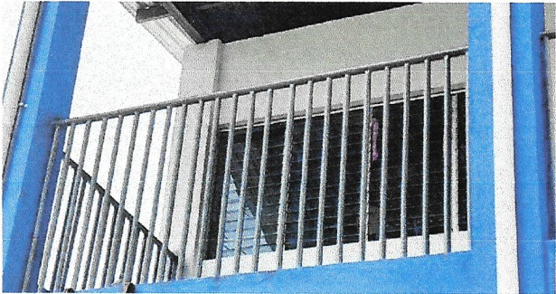
Foto 3: Mantenimiento a barandas
