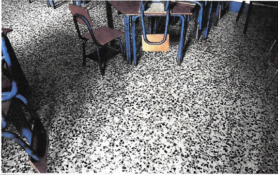
Foto 2: Sustitución de piso de granito
