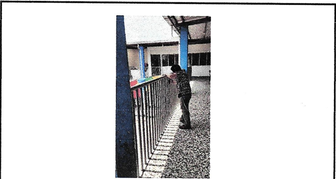
Foto 3: Mantenimiento a barandas
