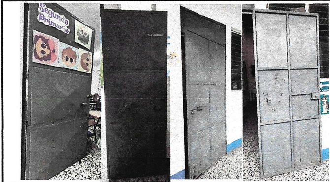
Foto1: Mantenimiento a estructura y sustitución de chapa
