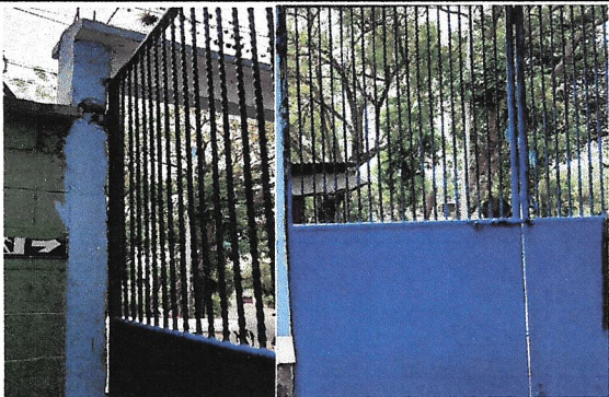
Foto 4: Mantenimiento a portones
