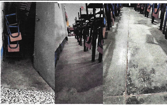
Foto 2: Sustitución de piso de granito
