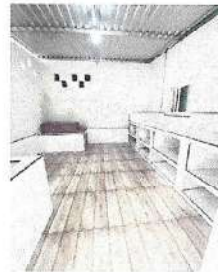
Foto 10: Reparación de cocina
