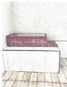
Foto 11: Sustitución de estufa rural
