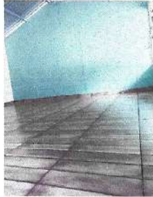
Foto 7: Reparación de piso de torta de concreto
