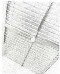
Foto 1: Sustrucción de lámina, por lámina troquelada
