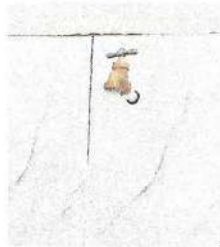
Foto 9: Sustitución de llave de choro
