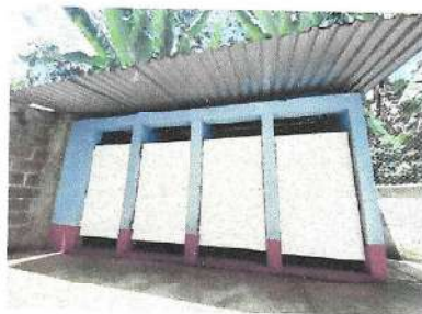
Foto 4: Sustrucción de puertas de servicios sanitarios
