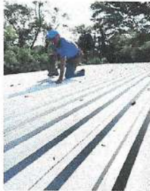
Foto1: Sustitución de lámina, por lámina troquelada
