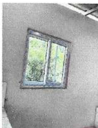
Foto 5: Sustitución de ventanas de madera por metal más vidrio
