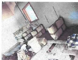
Foto 10: Reparación de cocina
