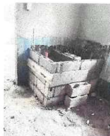
Foto 12: Sustitución de pila de cemento de dos lavaderos
