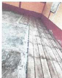
Foto 8: Reparación de piso de torta de concreto
