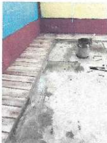
Foto 7: Reparación de piso de torta de concreto
