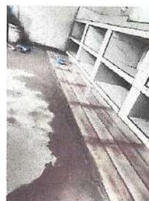
Foto 6: Reparación de piso de torta de concreto
