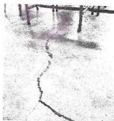
Foto 8: Reparación de piso de torta de concreto
