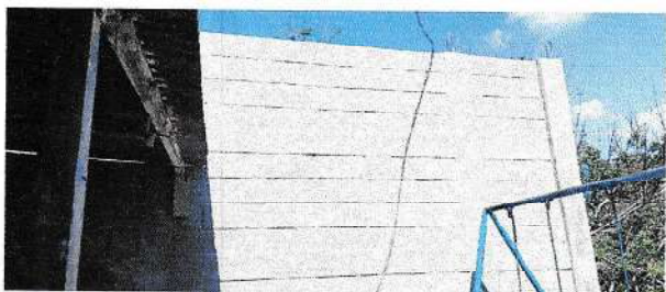
Foto 3: Repello, cernido y alisado de paredes.
