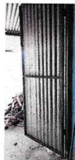
Foto 4: Sustitución de puertas
