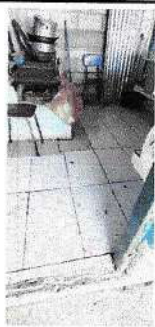
Foto 5: Sustitución de piso cerámico
