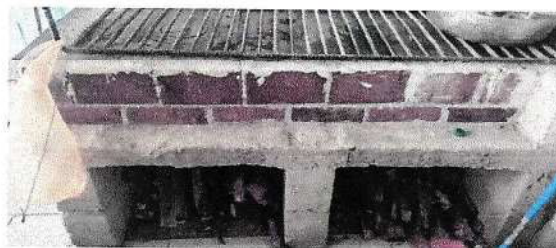
Foto 6: Sustitución de chimenea de metal
