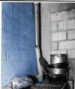
Foto 3: Sustitución de chimenea de metal
