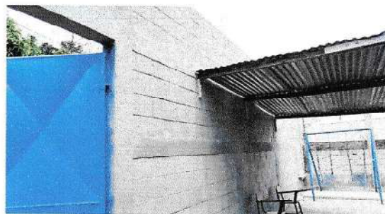
Foto 2: Pintura en muros exteriores e interiores
