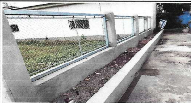
Foto 2: mantenimiento y cambio de malla de muro perimetral
