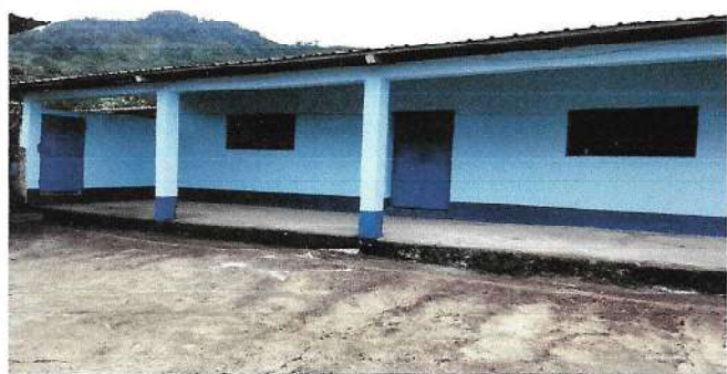
Foto1: pintura exterior de escuela
