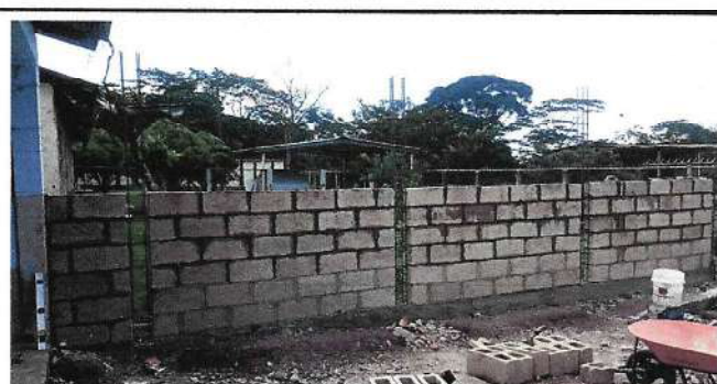
Foto 6: reconstrucción de Muro perimetral
