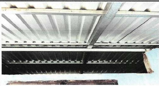
Foto1: Cambio de constanera de madera por metal en techo de cocina
