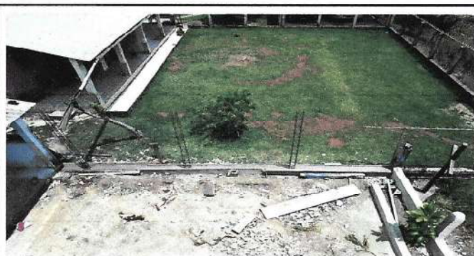
Foto 3: levantamiento de muro perimetral
