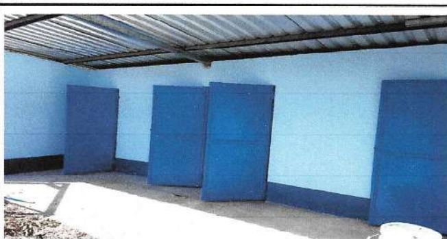
Foto 5: mantenimiento de baños
