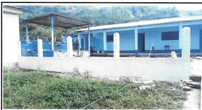
Foto 4: pintura de exteriores e interiores
