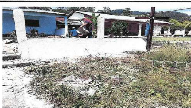
Foto 2: mantenimiento y cambio de malla de muro perimetral
