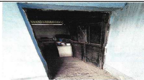
Foto 4: mantenimiento de puerta de cocina
