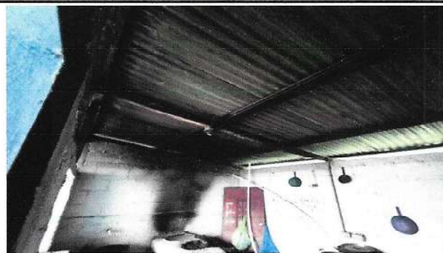
Foto 2: cambio de estructura de madera por tubo galvanizado
