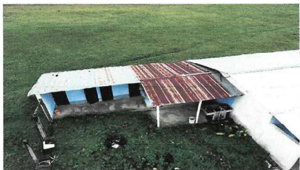
Foto1: cambio de techo de cocina y baños
