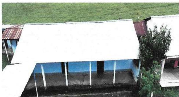
Foto1: Colocación de canal frontal
