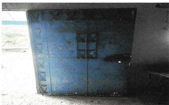
Foto 3: mantenimiento de puertas de salones, lijado, oxido y pintura
