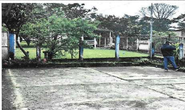
Foto 3: levantamiento de muro perimetral
