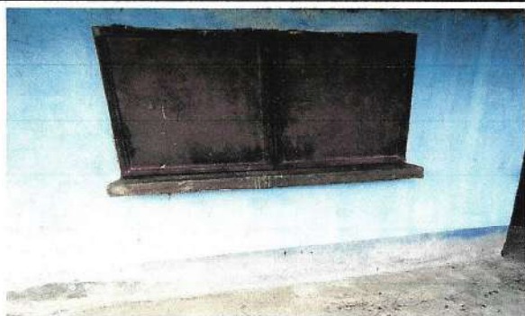
Foto 5: mantenimiento de Venta de cocina
