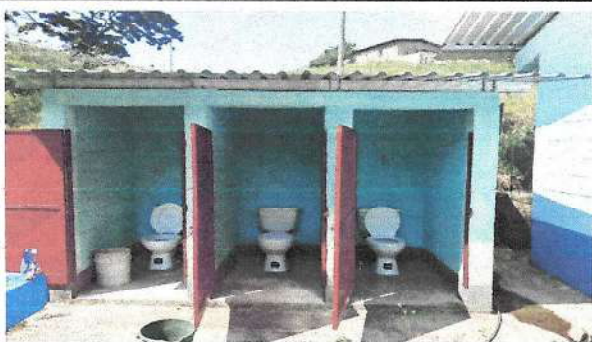
Foto 5: Mantenimiento de puertas de baño, y cambio de sanitarios completo.
