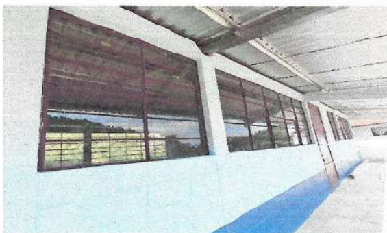
Foto 3: Mantenimiento de ventanas y vidrios, finalizado
