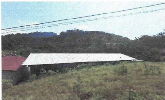
Foto1: Sustrucción de lámina troquelada realizado
