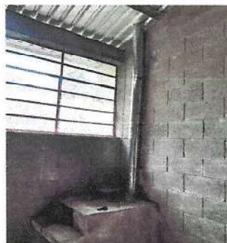
Foto 4: Mantenimiento de plancha de cocina terminado
