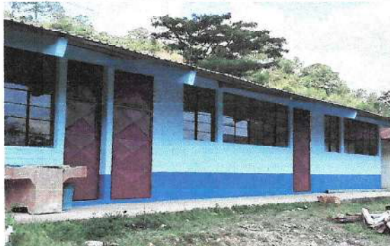
Foto 2: Cambio de costaneras realizado
