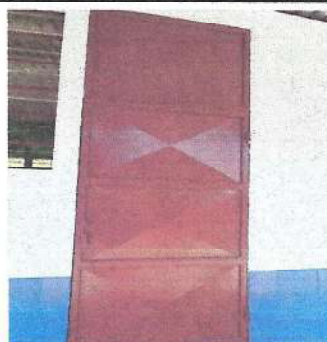
Foto 6: Mantenimiento de puertas grandes finalizado.
