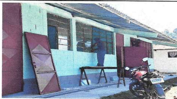
Foto 3: Mantenimiento de ventanas y vidrios
