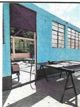
Foto 6: Mantenimiento de puertas grandes
