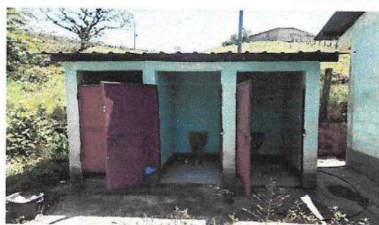
Foto 5: Mantenimiento de puertas de baño, y cambio de sanitarios
