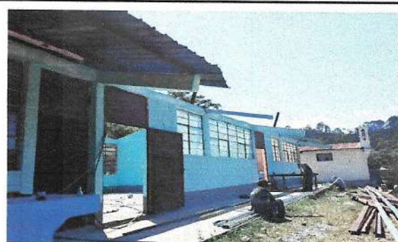
Foto 2: Cambio de costaneras
