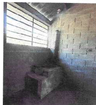
Foto 4: Mantenimiento de plancha
