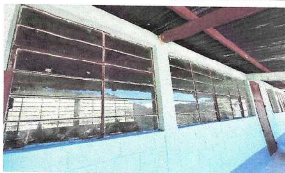
Foto 3: Mantenimiento de ventanas y vidrios
