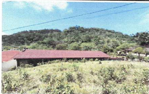
Foto1: Sustitución de Lamina troquelada
