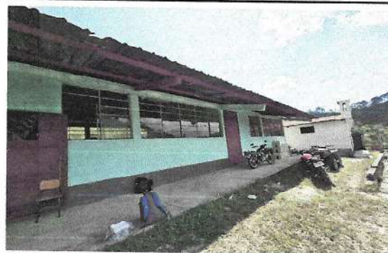
Foto 2: Cambio de costaneras
