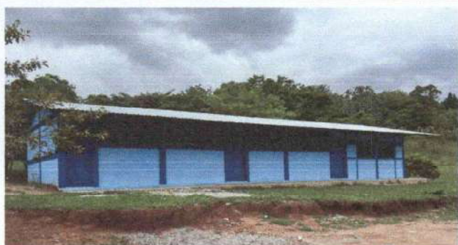
Foto 3: SUSTITUCIÓN DE CAPOTES DE MADERA. POR CAPOTES DE METAL, ESCUELA FUNALIZADA.
