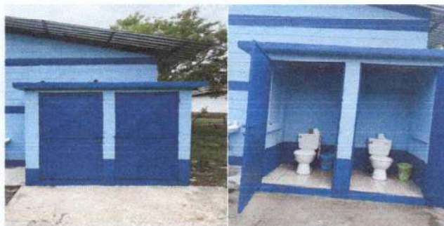
Foto 4: LIJADO DE PUERTAS, MÁS COLOCACIÓN DE PISO.
