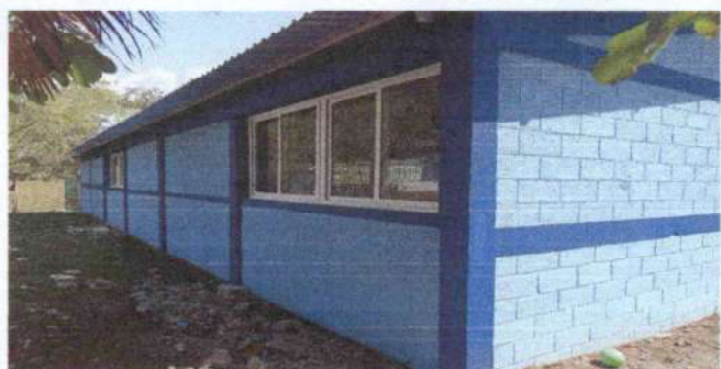
Foto 5: APLICACIÓN DE PINTURA EN INTERIORES Y EXTERIORES MÁS INSTALACIÓN DE VENTANAS DE PVC,
