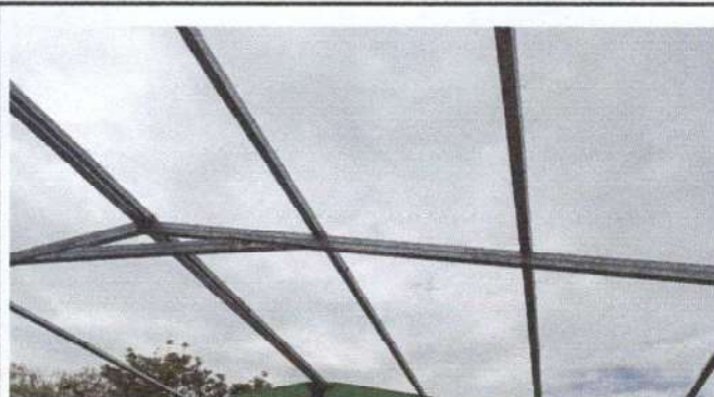
Foto 2: SUSTITUCIÓN DE ESTRUCTURA DE SOPORTE DE MADERA, POR SOPORTE DE METAL.
