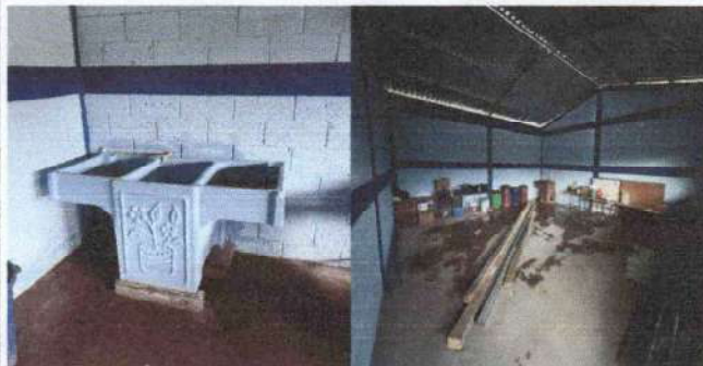
Foto 6: CAMBIO DE PILA DE PLÁSTICO A PILA DE CONCRETO.
