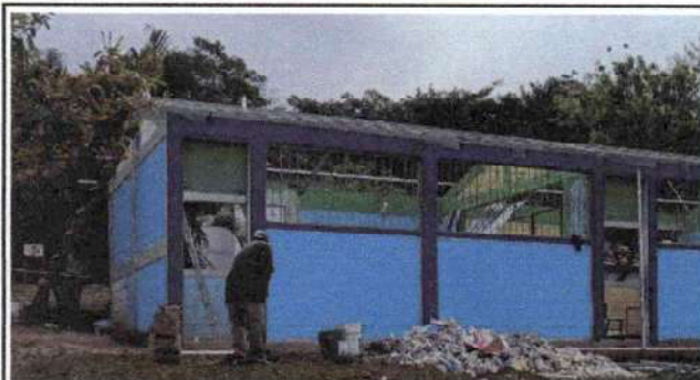
Foto 3: Sustitución de capote de madera por capotes de metal
