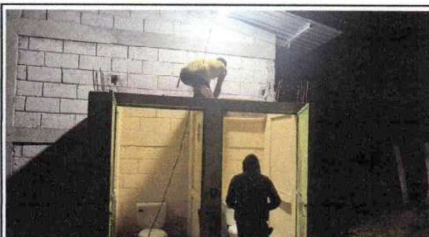
Foto 4: Sustitución de puertas en los servicios sanitarios
