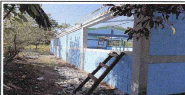
Foto 5: repello, aplicación de pintura en exteriores e interiores.
