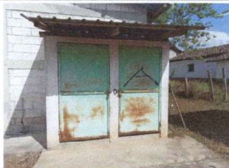
Foto 4: Sustitución de puertas en los servicios sanitarios
