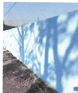
Foto 4: Muro perimetral con la seguridad necesaria del establecimiento.
