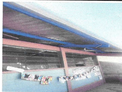
Foto 2: Lámina nueva instalada en condiciones necesarias.
