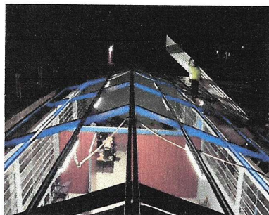
Foto 1: Preparación de estructura previa a instalar lámina
