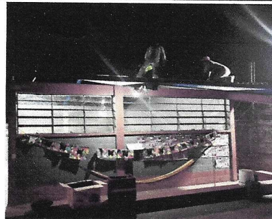
Foto 2: Inicio de sustitución de lámina.
