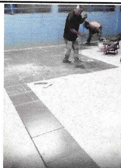
Foto 5: Instalación de piso cubriendo grietas que tenía.
