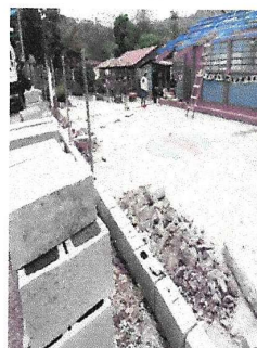
Foto 4: Instalación de block en muro perimetral para seguridad al establecimiento.
