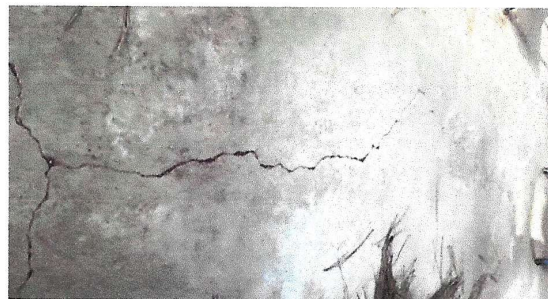
Foto 6: La mayor parte de piso de cemento líquido se encuentra deteriorado, causando un desnivel.
