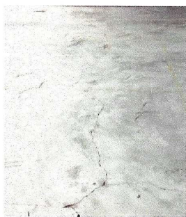
Foto 5: Grietas en el piso de cemento líquido debido a la antigüedad.
