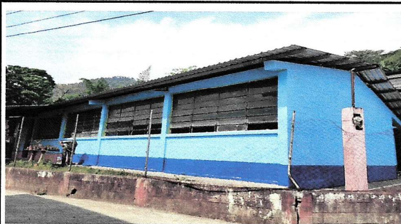
aplicación de pintura
