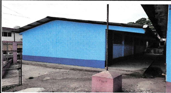
aplicación de pintura
