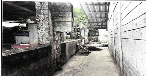
circulación de malla galvanizada
