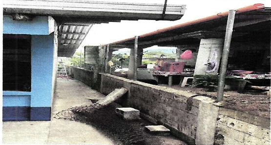
circulación de malla galvanizada
