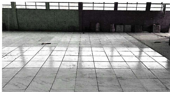
Instalación piso cerámico
