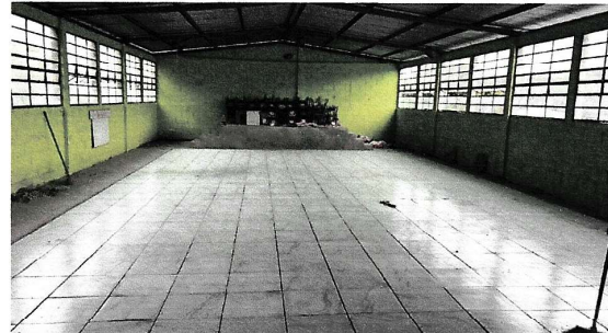
Instalación de piso cerámico
