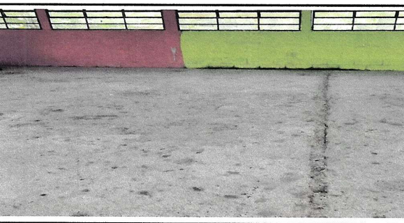
instalación piso cerámico
