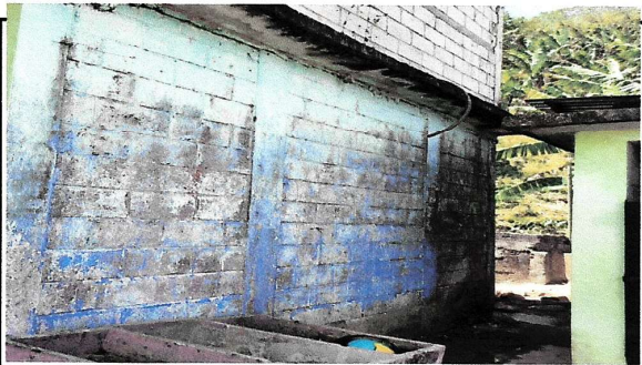
Aplicación de pintura
