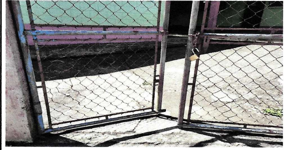
cambio de porton de entrada a la escuela
