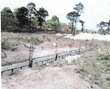
Foto 3: continuación de muro perimetral
