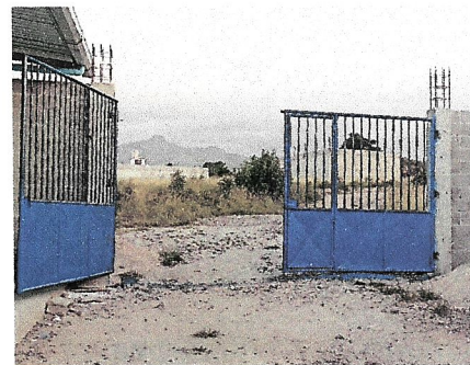
Foto 6: instalación de portón
