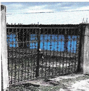
Foto 5: instalación de portón, incluye estructura y mano de obra
