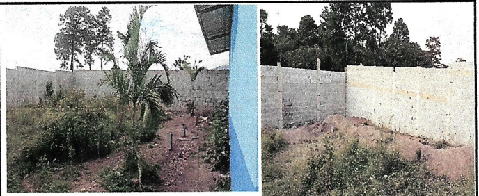
Foto 4: contuniación muro perimetral
