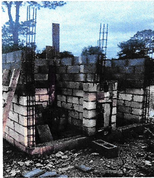
Foto1: instalación de servicios sanitarios y sus accesorios
