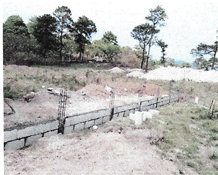
Foto1: Continuación de muro Perimetral
