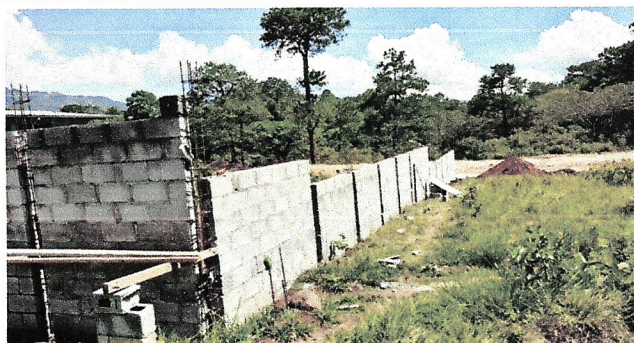
Foto 2: Avance de muro perimetral
