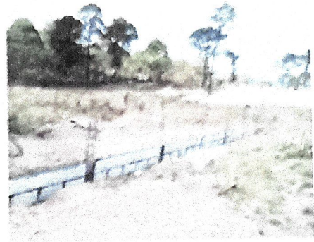
Foto 2: En esta área los padres de familia iniciaron la construcción del muro perimetral y trabajos de albañilería por día.
