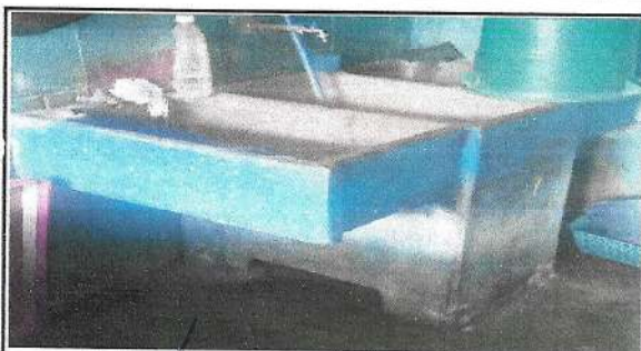
Foto 9: 8.1 Sustitución de deposito de agua de 1100 lt.
