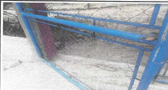
Foto 8: 7.1 Mantenimiento a Portones de Metal
