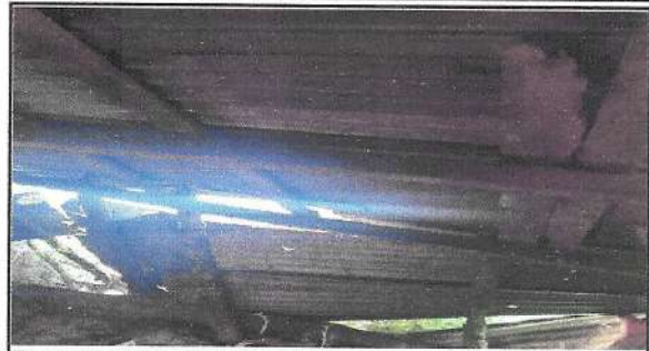
Foto 2: 2.2 Sustitución de Estructura de soporte de madera a metal
