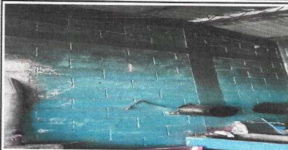
Foto 7: 6.1 Pintura en muros interiores y exteriores.
