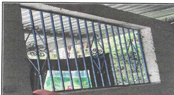
Foto 10: 9.1 Fabricación e instalación de Ventana
