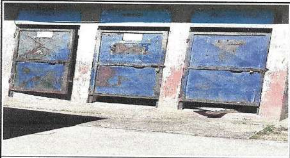
Foto 3: 3.1 Mantenimiento a Estructura
