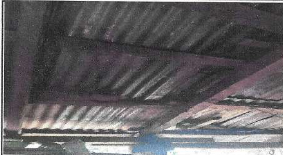
Foto 1: 1.1 Sustitución de lamina troquelada aluzinc calibre 26
