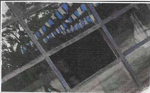
Foto 5: 4.2 Sustitución de Vidrios
