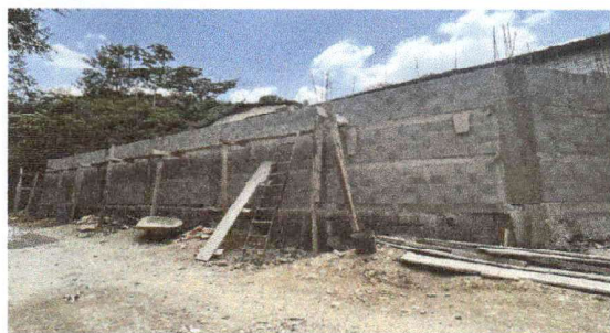
Foto 1: Reparación de muro de contención
