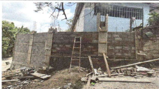
Foto 3: Reparación de muro de contención
