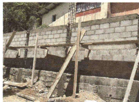
Foto 2: Reparación de muro de contención
