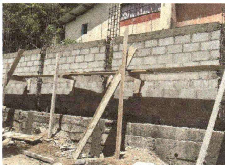
Foto 3: Reparación de muro de contención
