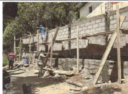
Foto 2: Reparación de muro de contención
