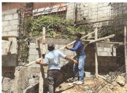
Foto1: Reparación de muro de contención
