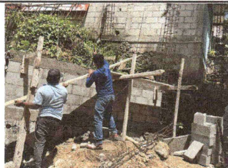
Foto 4: Reparación de muro de contención
