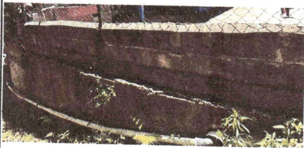
reparacion de muro de contención
