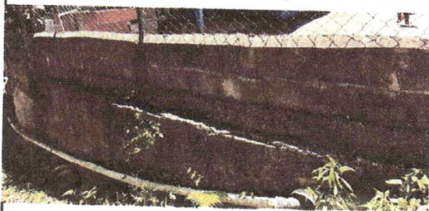
aplicación de repello de contencion
