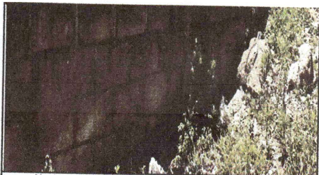
reparación de muro perimetral de block
