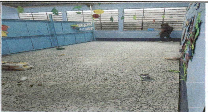
Instalación de piso de granito
