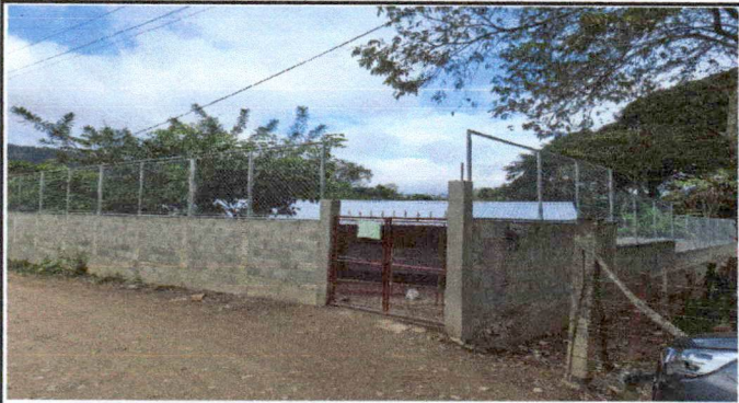
Circulado con malla galvanizada con tubo galvanizado en muro perimetral
