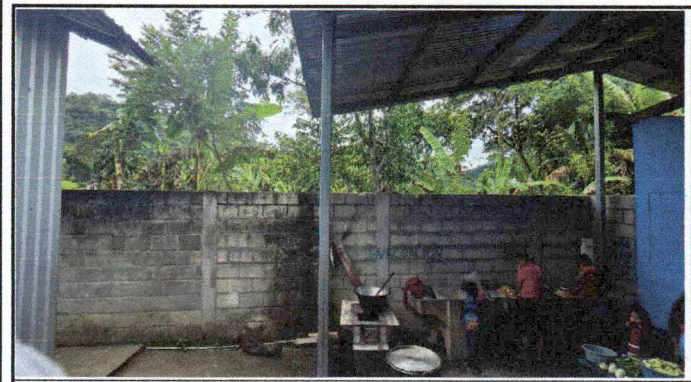
Circulado de muro perimetral.
