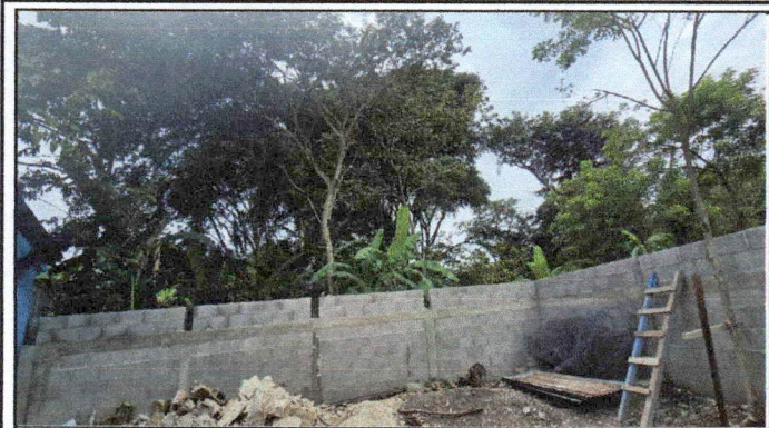
Circulado de muro perimetral.
