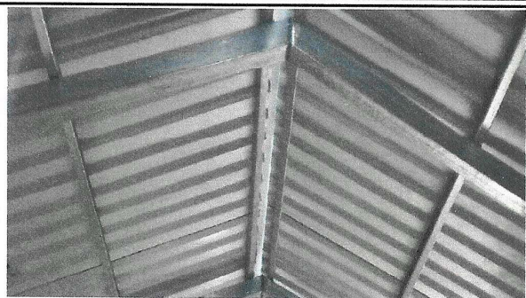
Foto 1: CUBIERTA DE LAMINA
