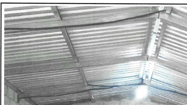
Foto 4: REPARACION DE SISTEMA ELÉCTRICO
