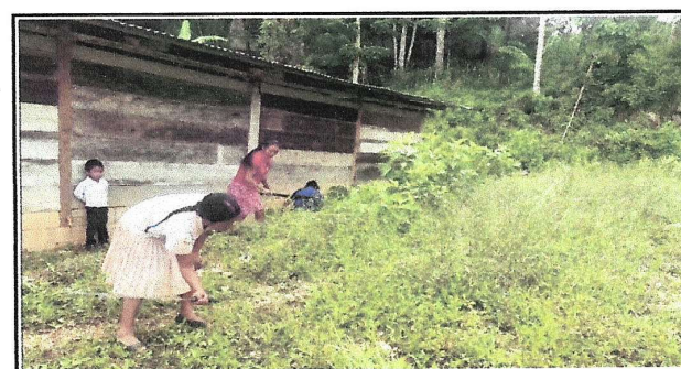
Foto 6: REPARACION DE REPELLO Y CERNIDO DE PAREDES
