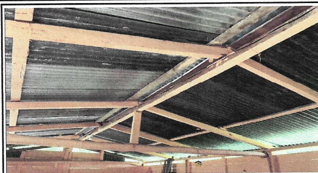
Foto1: CUBIERTA DE LAMINA
