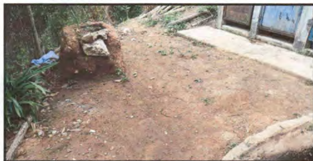
Foto 7: Reparación de planchas de cemento de patio
