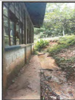
Foto 5: Reparación de cuneta de cemento
